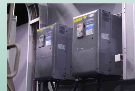
空調冰水系統全面裝設變頻器
