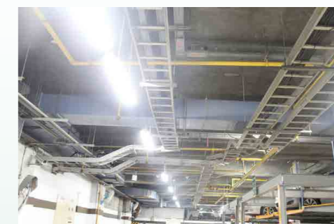
停車場照明燈換裝 LED 燈具
