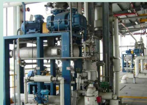
以真空泵浦取代蒸汽噴射器
