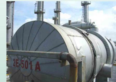
製程廢熱排放管路增設熱交換器以加熱蒸氣鍋爐餵水
