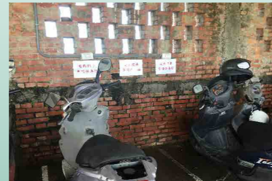
電動機車充電區
