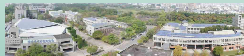
屋頂太陽能發電系統
