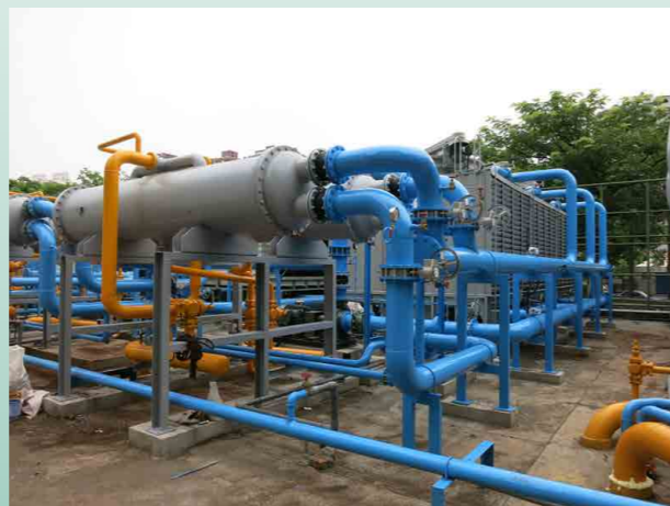
戶外冷凝水塔更新
