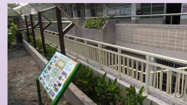
勝利樓地下室導風板
