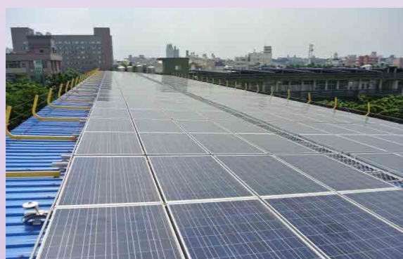
校舍屋頂裝設太陽能板
