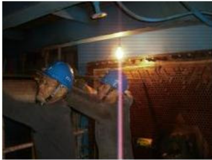
(3)冷凝管切管、拔管工作
