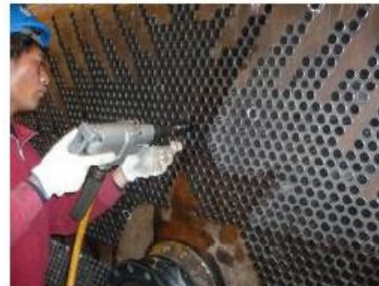
(5)切管、修管後之擴管工作
