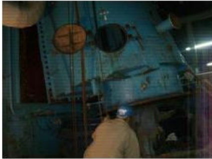
(1)水箱端蓋拆解
