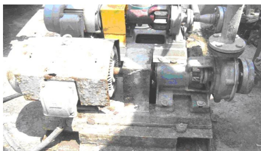
1. 加壓浮上槽泵浦改善
