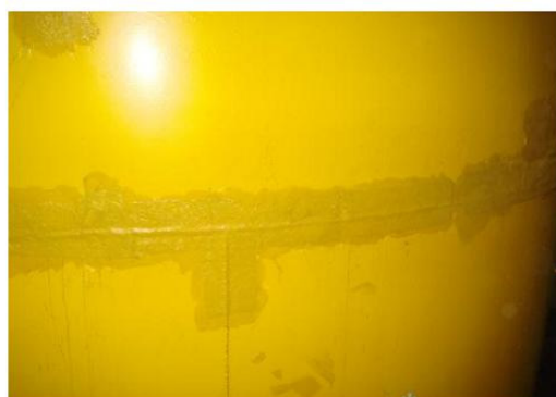
原槽體鋼板焊接外圍部份及內部鏽蝕嚴重部再以 FRP 披覆加強防鏽功能
