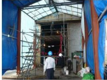
(2)搭建作業平台
