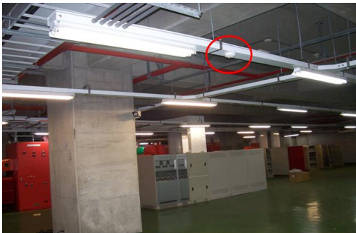
變電室日光燈具裝設紅外線感應器
