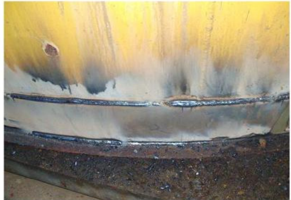
已於底部除鏽及防鏽手續後以 1 公分厚鋼板環繞焊住，加強槽體安全性
