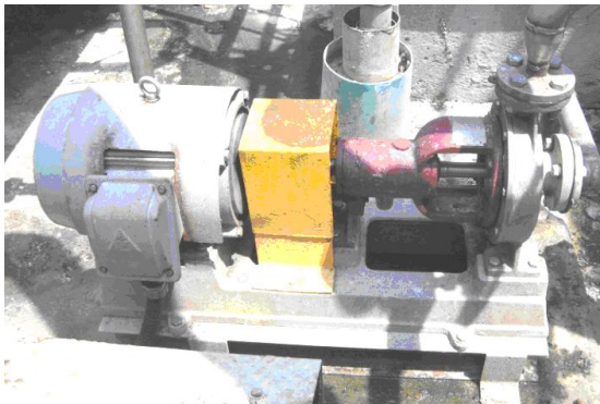
1.加壓浮上槽泵浦改善
