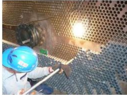
(4)新冷凝管穿管工作
