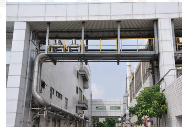
跨棟空調冰水管路合併
