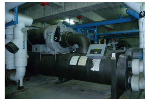
建置中央空調主機智慧化節能控制系統
