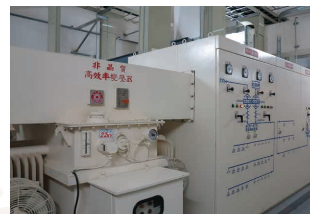
非晶質高效率變壓器
