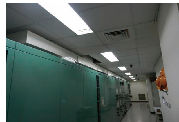
變電所控制室空調改善系統
