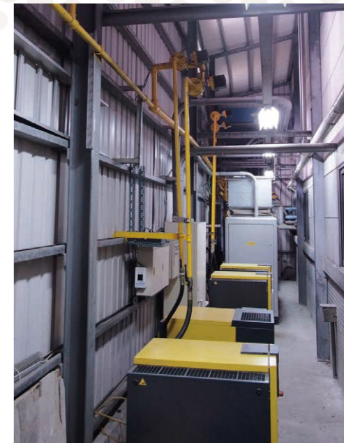
ABCD 棟空壓機管路併連
