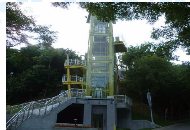
戶外電梯採用高效率馬達及綠能照明
