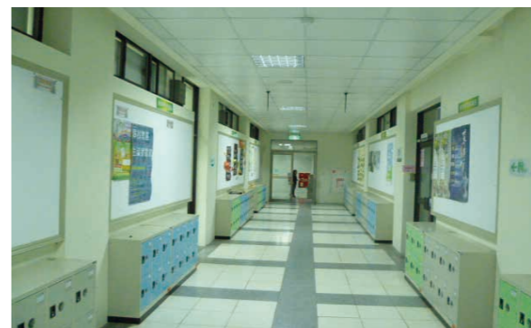
建築物公共空間換裝 LED 照明燈
