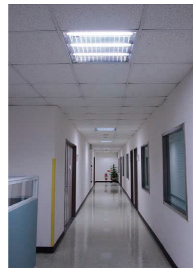
ABCD 棟傳統 T8 照明燈具更換為 T5 節能燈具
