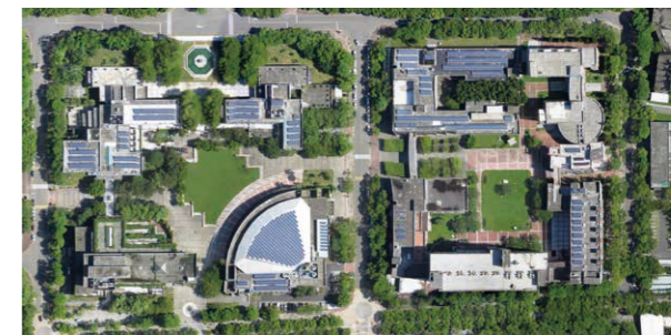
屋頂太陽能發電系統空照圖
