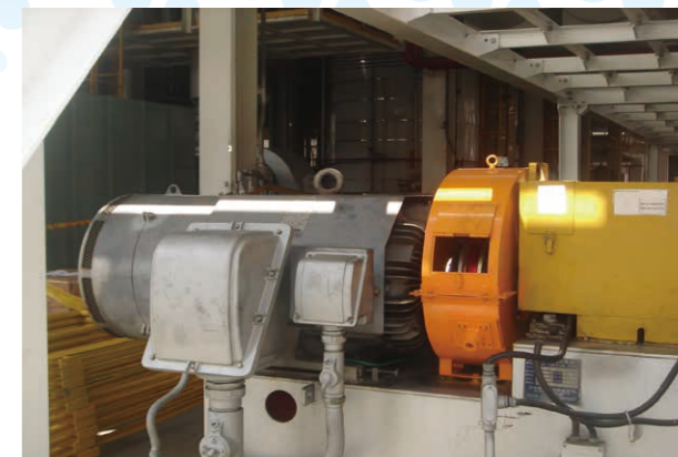
永磁聯軸器風車節能
