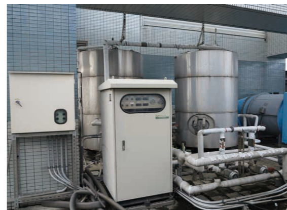
雙效型熱泵系統
