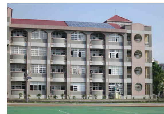
篤行樓屋頂建置太陽光電發電系統
