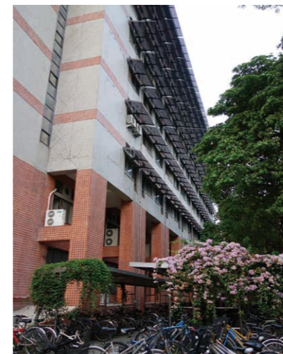
工程三館南向立面外遮陽
