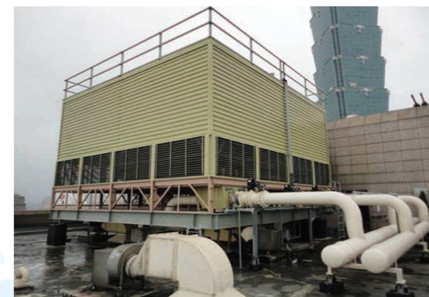
冷卻水塔節能
