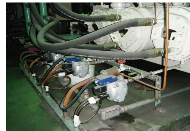
空壓機汰舊換新 (2)
