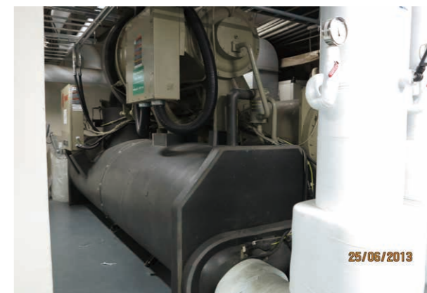
冰水主機汰換推舊換新
