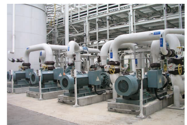
淡鹽水熱回收系統 - 泵
