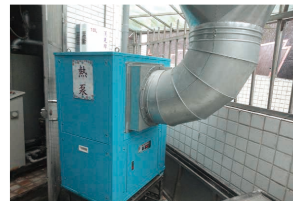
自立廚房熱泵系統
