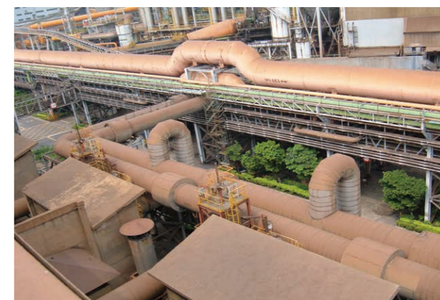
動力工場鼓風機冷鼓風管網
