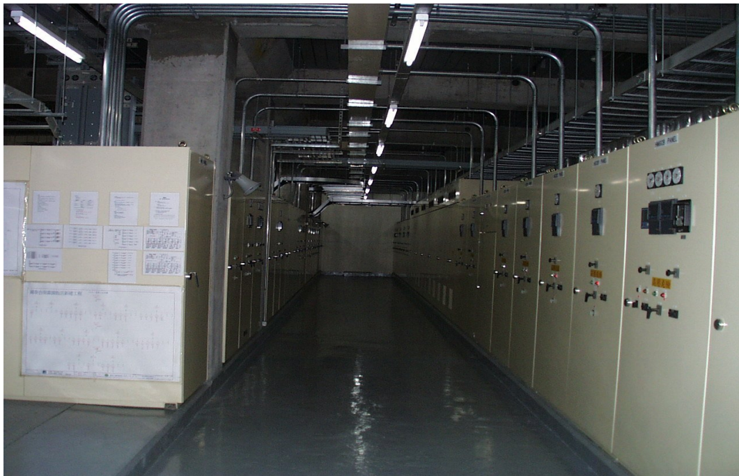
相片 6.3-1 高低壓配電系統能
