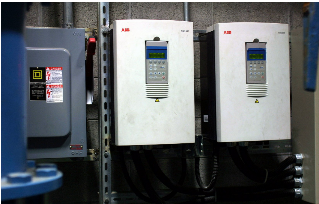
相片 6.3-11 空調冰水及冷卻系統
