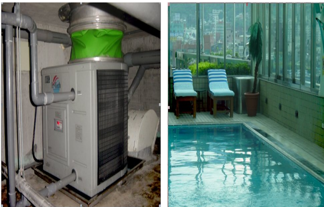
相片 6.3-19 游泳池熱泵加熱系統
