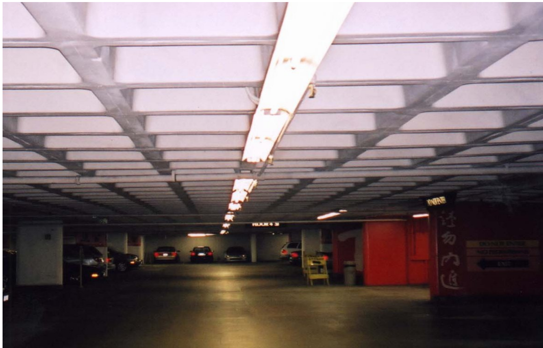
相片 6.3-8 地下停車場日光燈照明系統
