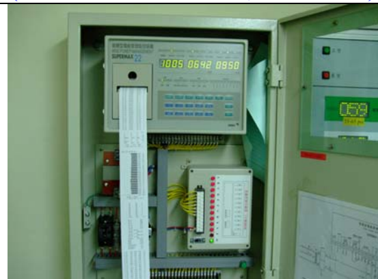
電能需量控制系統
