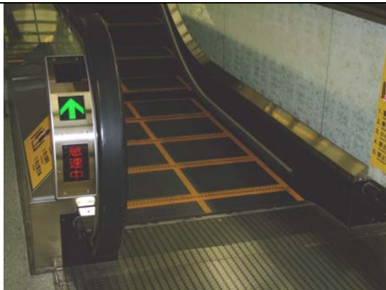
電扶梯採用感應馬達加裝變頻器 (當購物人少時，可調降轉速節約用電)
