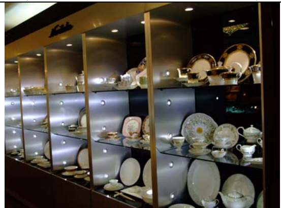
展示櫃照明採用 LED 燈具取代鹵素燈 (可省電 82%)
