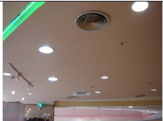
選用高效率光源 (採用複金屬燈或省電燈泡當基礎照明)
