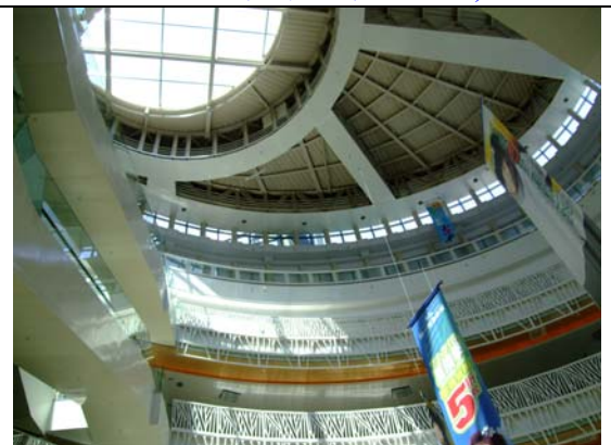
屋頂採用變頻控制抽排風散熱 (可自動控制減少抽排風散熱運轉耗電)
