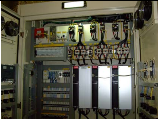
區域泵變頻器 (隨現場空調需求調整冰水流量， 節約泵浦用電)
