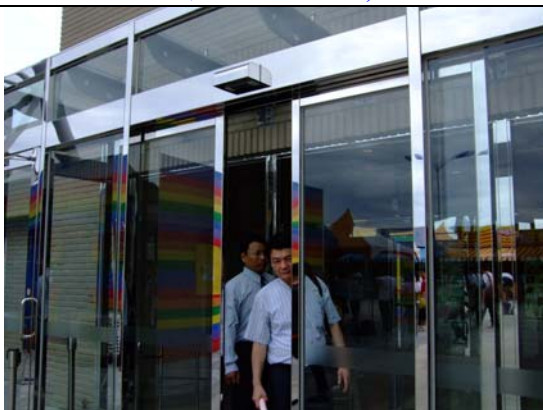
裝自動門防止冷氣外洩及熱氣侵入 (可降低空調負荷，節約空調用電)
