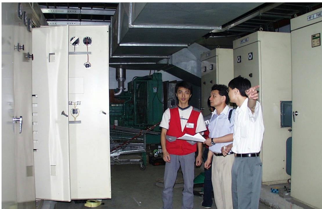
省能方法：採用高效率乾式變壓器，設有自動功因調整器 APFR 控制功因。
