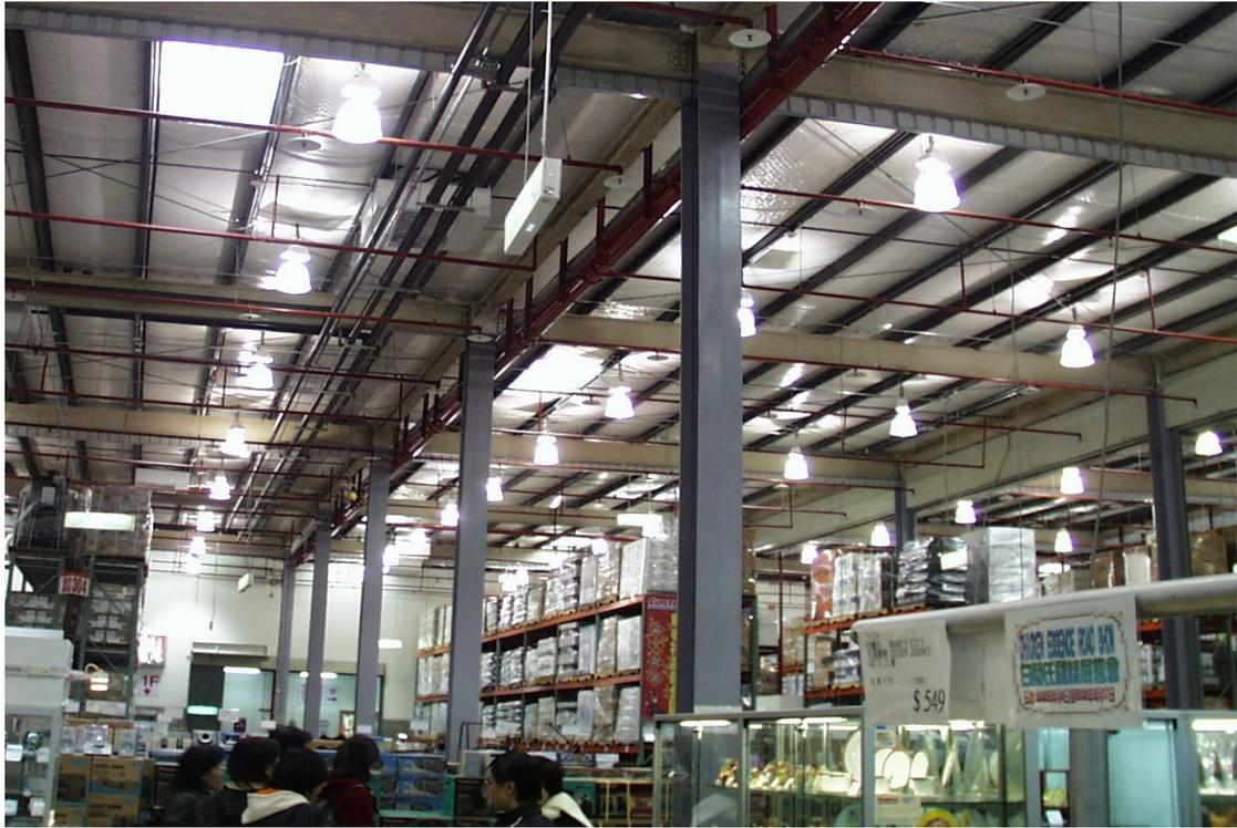
省能方法：賣場高度超過 4m 以上，採用透明擴型散大瓦數高效率複金屬燈。
