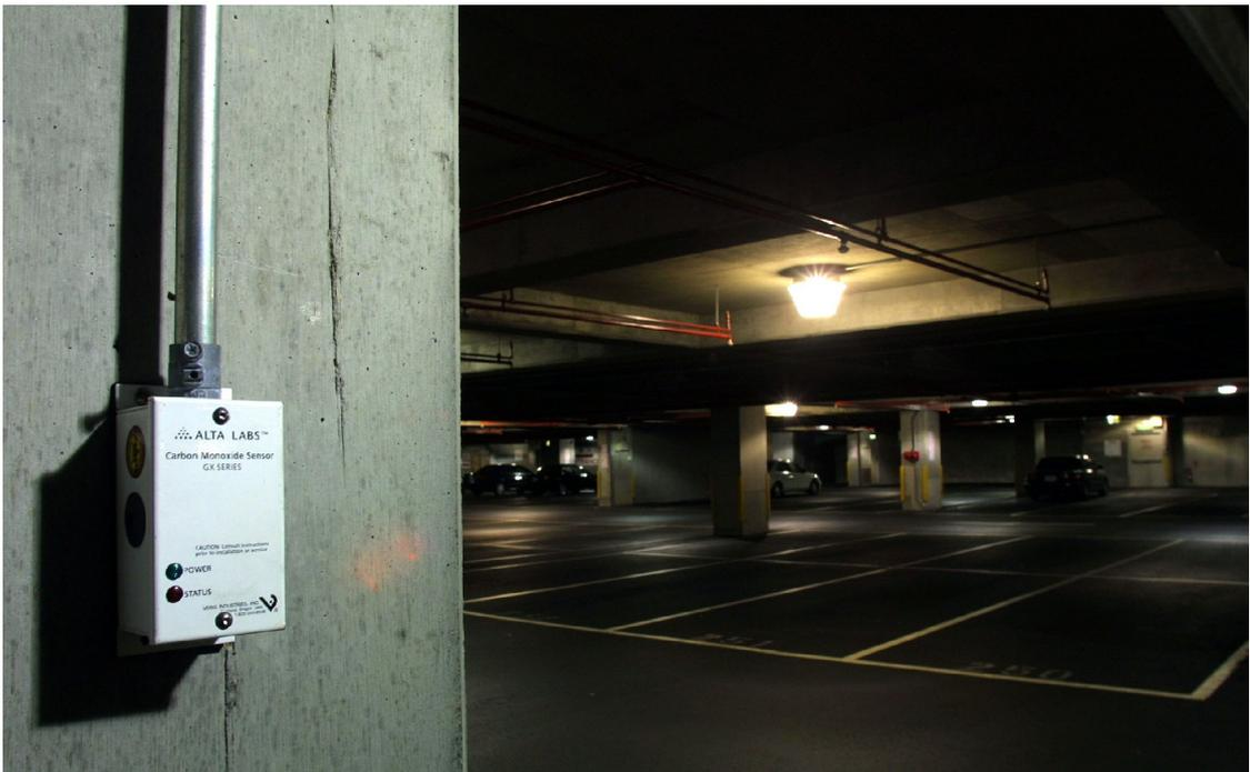
省能方法：採用 CO2 控制器。控制停車場通風設備運轉。
