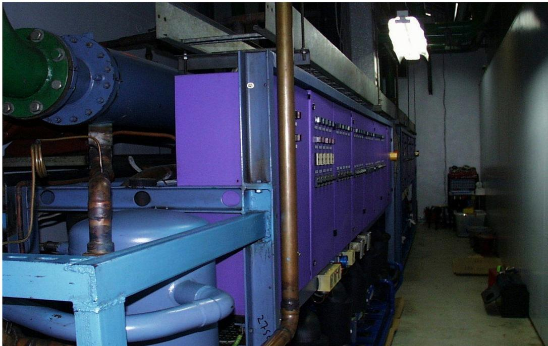
省能方法：分冷凍及冷藏系統，集中供應冷凍冷藏櫃所需冷能，
