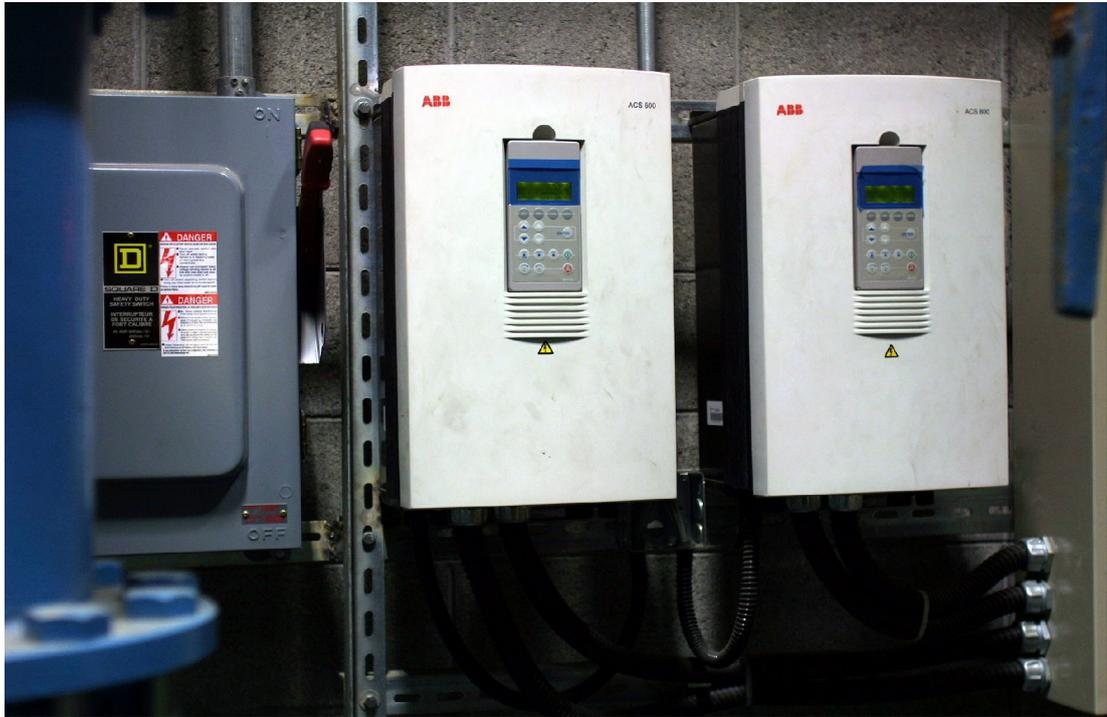
省能方法：採用變頻器控制，高效率冰水及冷卻水泵運轉，減少用電。
