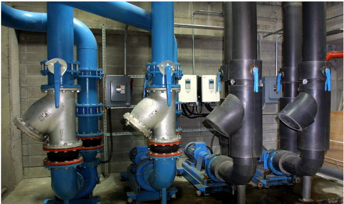
省能方法：採用高效率冰水及冷卻水泵，減少用電。
