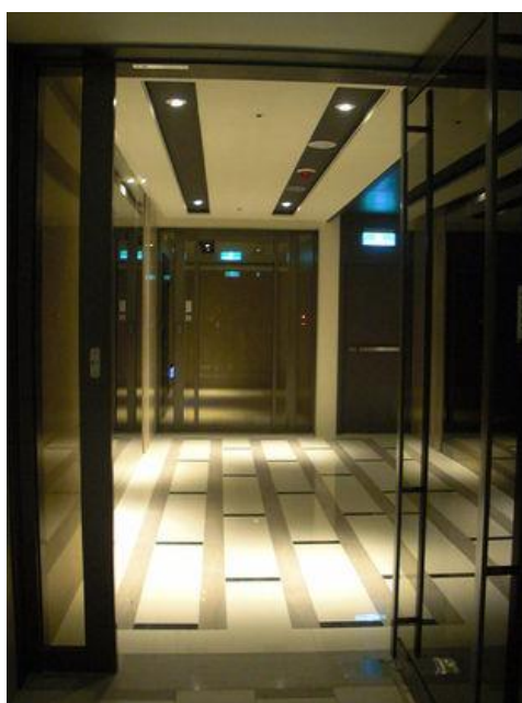
圖 5.3-9 門廊樓梯間照明採用 LED 燈源【36】
