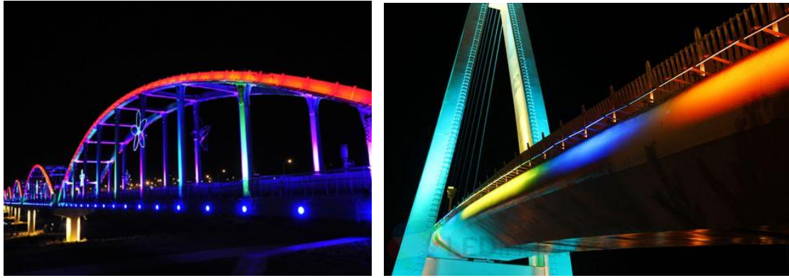
圖 3.2-1 LED 照明產品應用於橋樑實照圖
