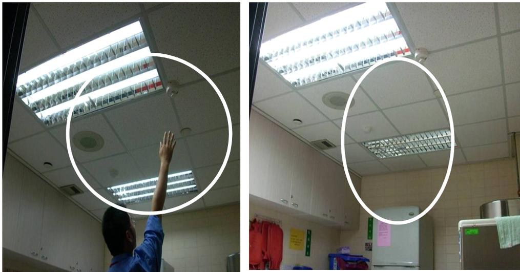
圖5-26 利用紅外線感測器控制開關燈具
