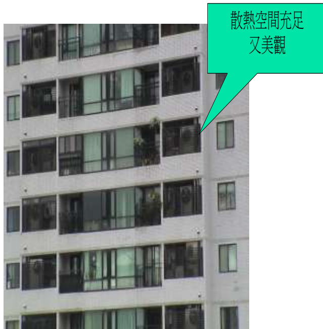
圖 5.2-3 室外機散熱通風空間充足且美觀之安裝
