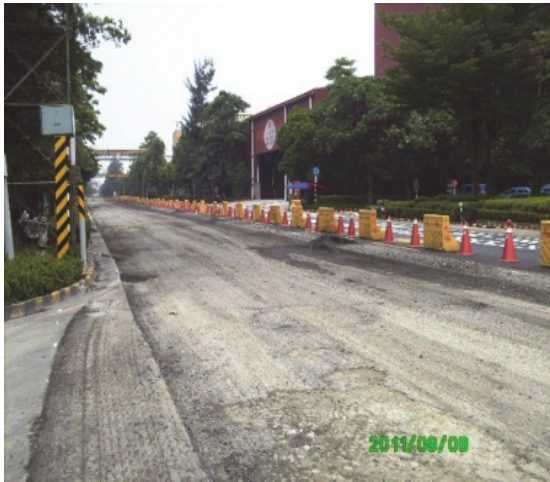
廠內道路鋪築
