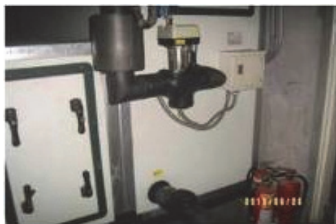
圖 9.比例式控制閥控制現場溫度
