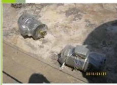
說明：冷卻水塔風扇馬達更換
