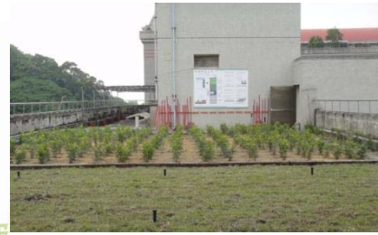
教學大樓頂樓隔熱裝置
