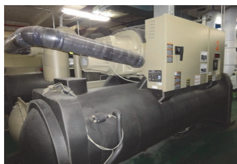
圖 8.安裝高效率螺旋式冰水主機
