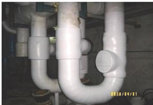
圖 4.拆除後一次側冰水泵
