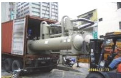
圖 7.吊掛高效率螺旋式冰水主機
