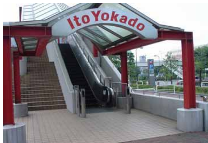
圖 7.3-3 日本百貨商場入口設置自動感測可變轉速手扶梯應用(例)
