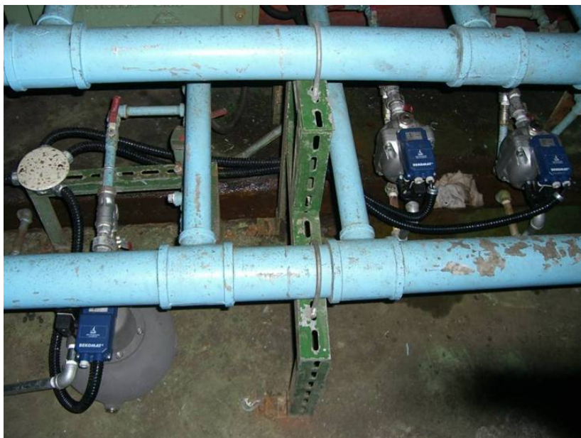
圖15 排水器安裝後
