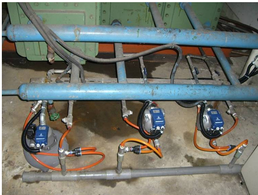
圖19 排水器安裝後
