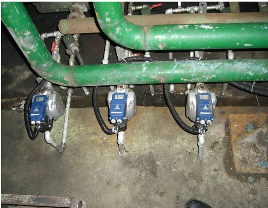
圖17 排水器安裝後
