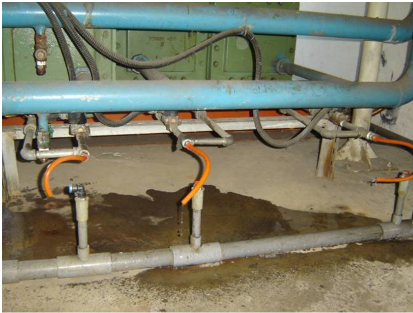
圖18 排水器安裝前
