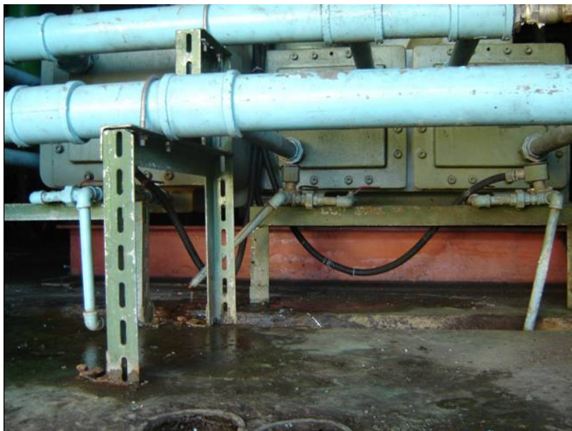
圖14 排水器安裝前
