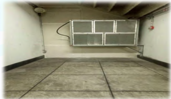
增設遮光隔熱設施(施作後)
