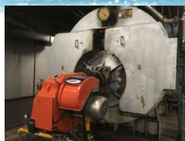
鍋爐燃燒機汰換(改用潔淨能源) 減碳1,224噸/年
