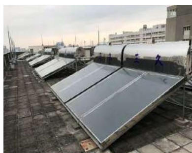
再生能源太陽能熱水器
