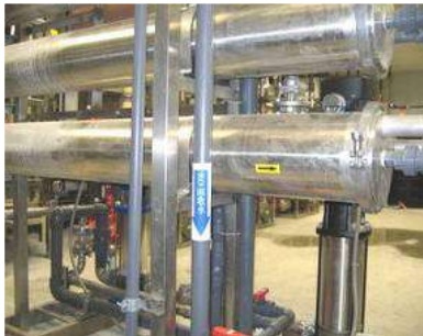
RO排放水回收
