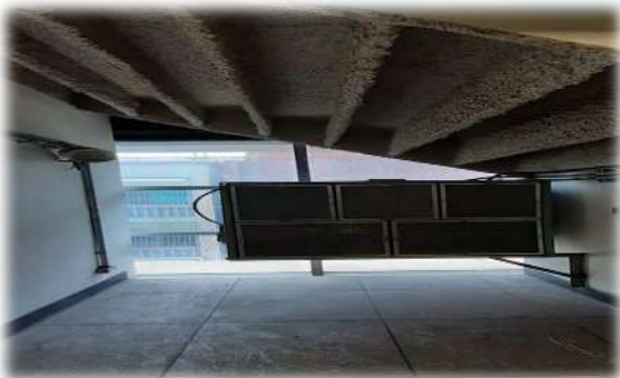
原玻璃帷幕外牆內側(施作前)
