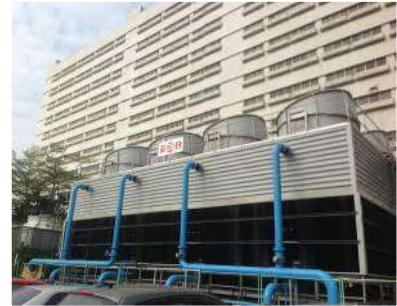
#3.4.6.7冷卻水塔汰換
