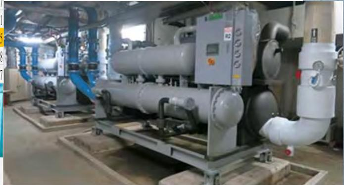
107年更換R1及R2冰水主機，採用堃霖KLFW-250D，性能879kw，半密螺旋式壓縮機，電源為3相380v60Hz，耗電量約166KW。廠測冰水主機能源效率 (COP) 為5.44、5.36，高於公告標準該級別效率4.90，原有主機測試紀錄為3.5，以年運轉2,220hr估算年節約用電為 $[(5.44-3.5) + (5.36-3.5)] / 3.517 \times 250(\text{RT}) \times 2,220(\text{Hr}) = 601,009\text{Kwh}$
