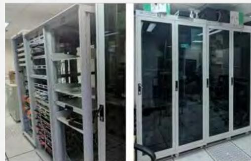
109年增設拉門, 完成(機櫃型空調)冷熱通道獨立。設定空調溫度27度(調高1度), 節省空調主機用電。經量測改善前每日用電約102度, 改善後為87度, 約減少15%。
