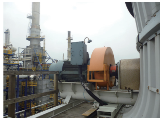
冬春季調降冷卻水流量節省泵浦電力 風車增設永磁式調速機
