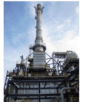
加熱爐增設節熱器改善
