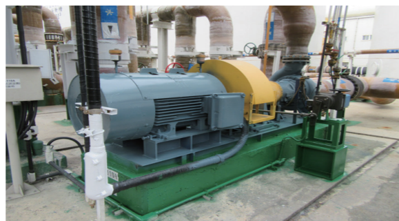
粗鹽水泵浦永磁式調速器節電
