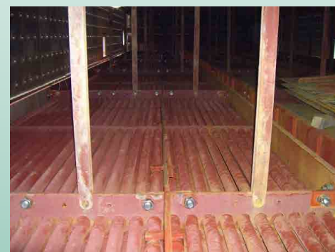
熱回收鍋爐改善 - 爐管
