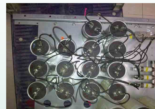
UPS 電容器改善 - 電容器組
