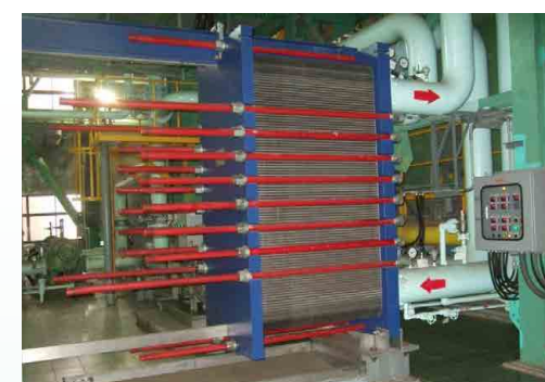
冷卻水系統改善 - 板式冷卻器
