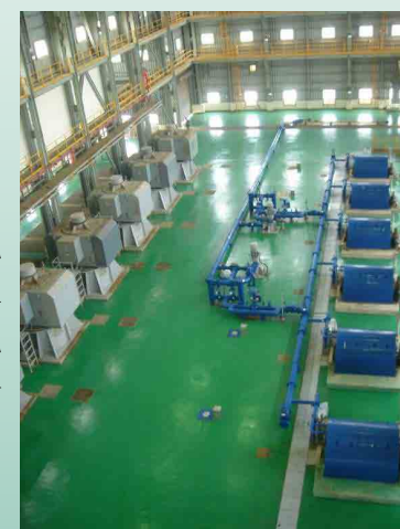
海水攔污沖洗泵改善 - 海水泵室
