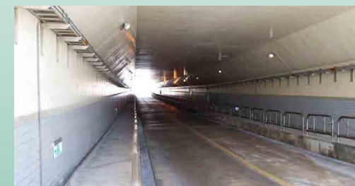
照明改善 - 車行地下道燈具
