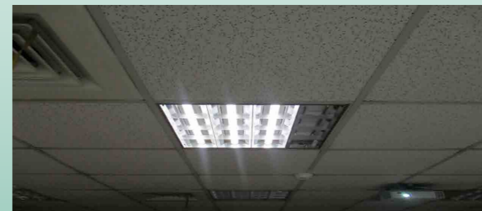
照明改善 - 採用 LED 燈管，且減少燈具數量達到節能效果
