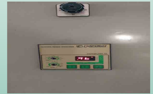
功率因數調整 - 加裝電容器提升用電效率
