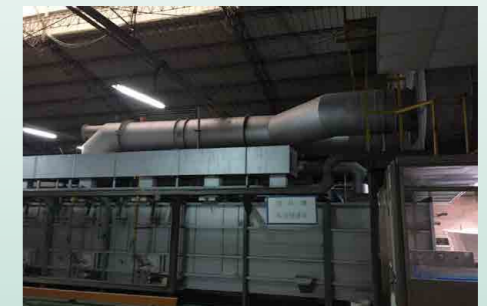
能源回收再利用 - 窯爐餘熱回收再利用
