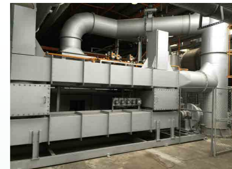
VOC 廢熱回收設備
