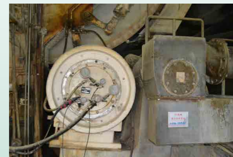
電力能源改善 -15 號機抽吸輻包膠由橡膠改為新型 PU 材質
