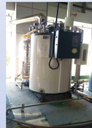
鍋爐瓦斯節能改善 - 新增 Local 鍋爐以降低主系統鍋爐壓力
