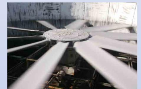
冷卻水塔更換節能葉片
