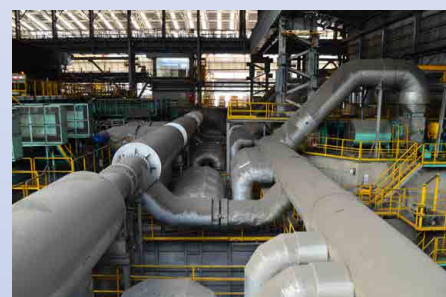
修改復熱器設計提高熱回收效率
