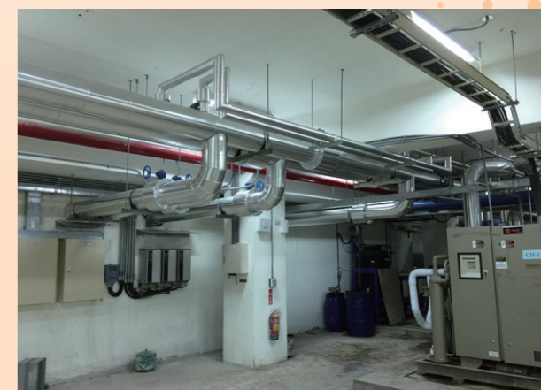
五館空調系統整併提昇效率
