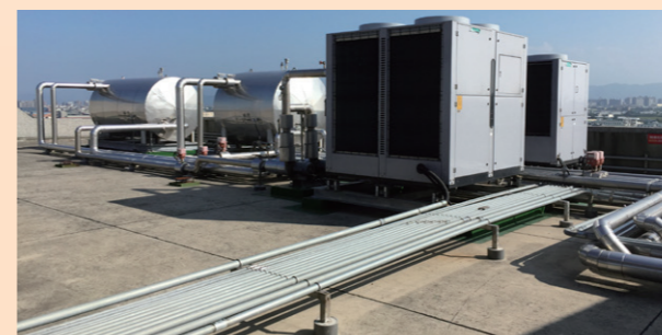
男女二舍淋浴用熱水新設熱泵系統
