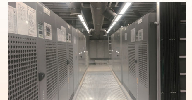
高效率通信機房
