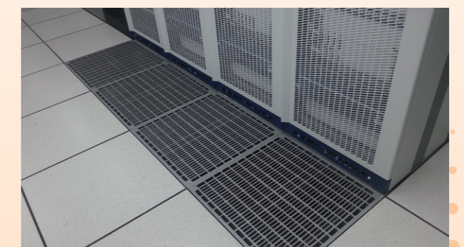
機房氣流節能改善
