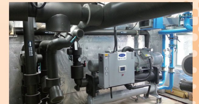
滿液式高效率空調主機更換
