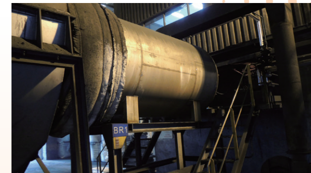
以雜酚油取代石油為原料 - 烘乾設備 BR1
