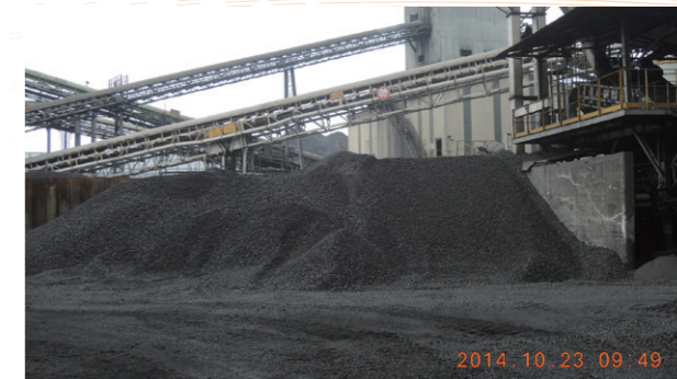
以雜酚油取代石油為原料 - 原料儲放位置
