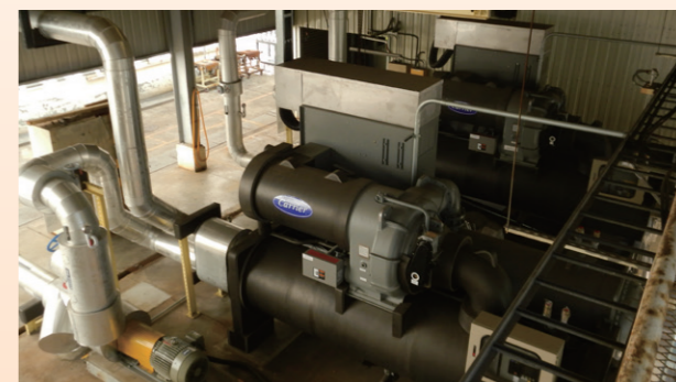
高效率冷凍機
