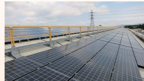
太陽能發電系統設置
