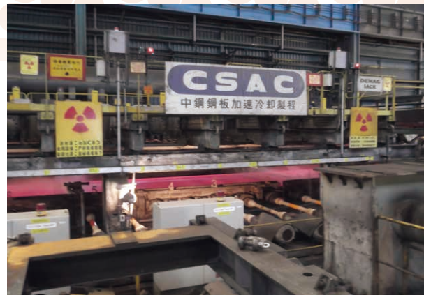
鋼板線上加速冷卻設備
