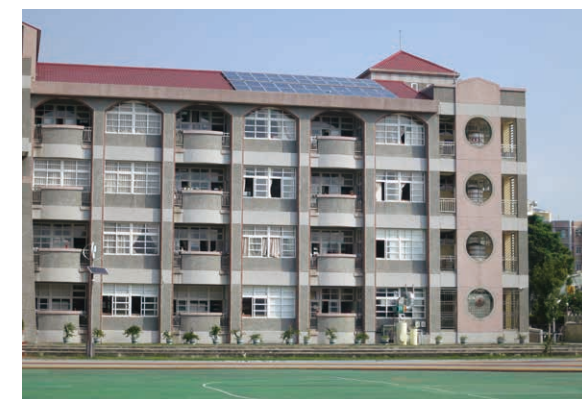
篤行樓屋頂建置太陽光電發電系統
