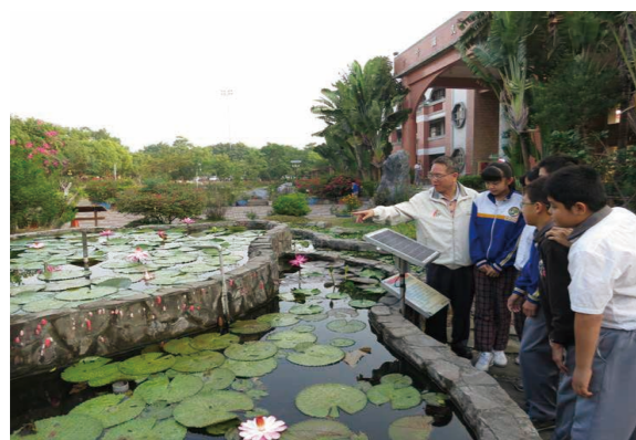
水生植物區太陽能幫浦
