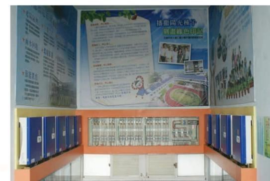
太陽能光電系統電流整流器
