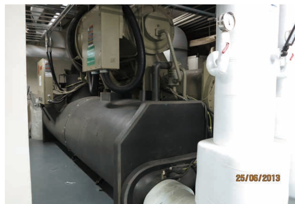
冰水主機汰換推舊換新
