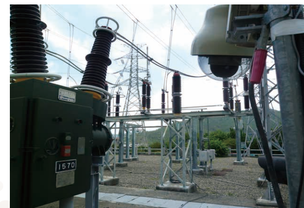
楓港變電所遠端監視操作
