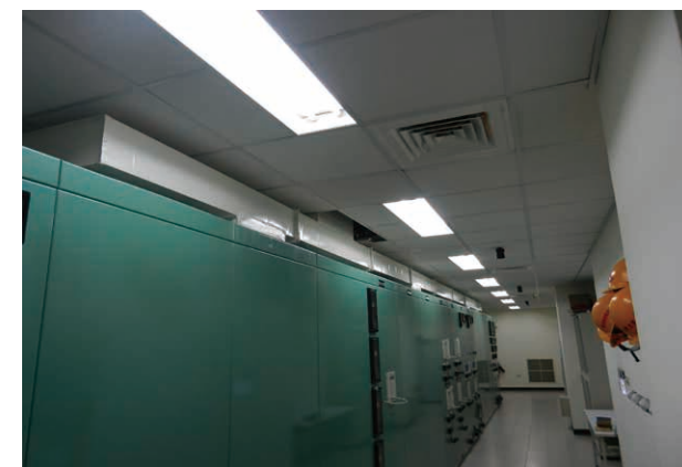
變電所控制室空調改善系統
