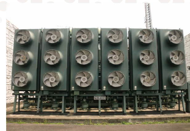
變壓器冷卻系統節能改善
