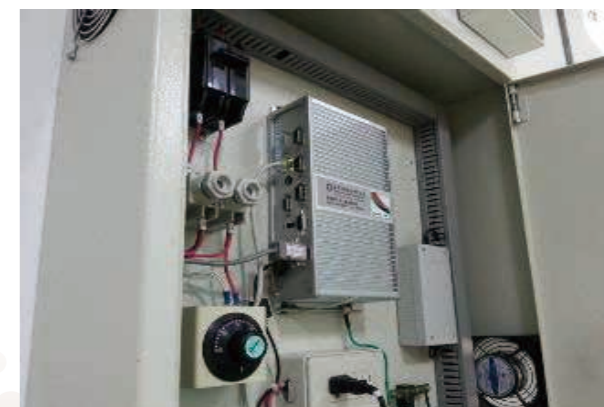
電力監控機制導入
