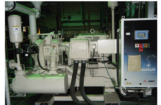
空壓機汰舊換新 (1)
