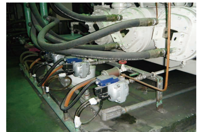
空壓機汰舊換新 (2)
