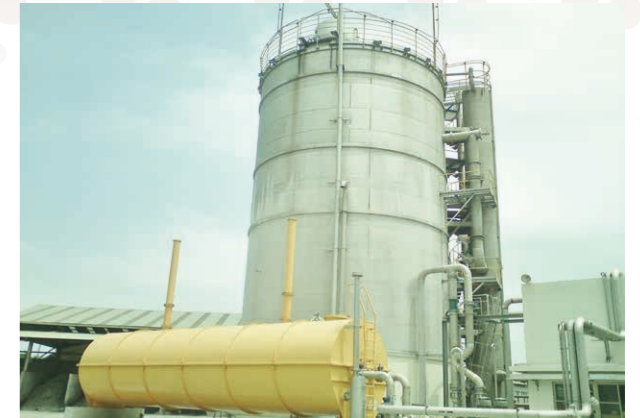
廢水處理增設厭氧前處理及沼氣回收再利用
