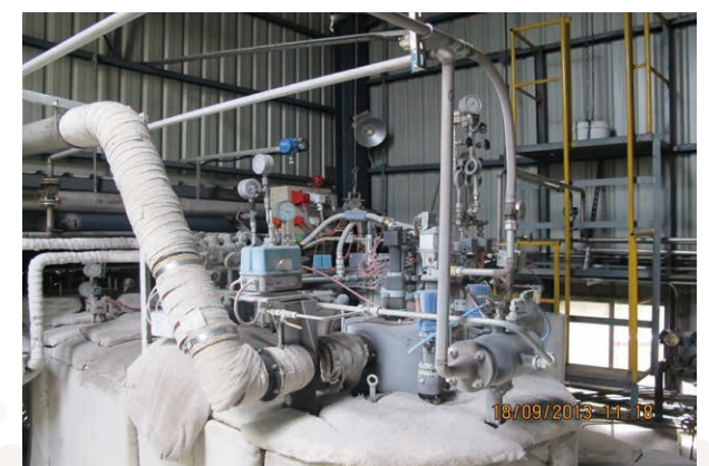
熱媒鍋爐燃油改天然氣
