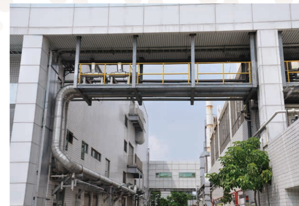
跨棟空調冰水管路合併
