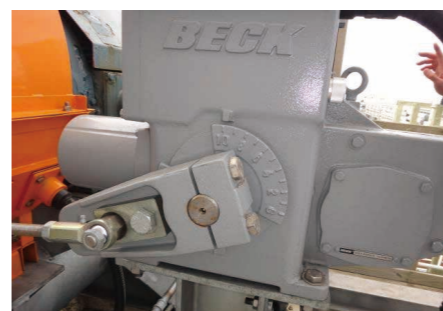
水塔風車永磁式調速器
