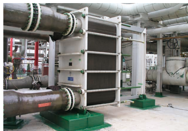
淡鹽水熱回收系統 - 熱交換器
