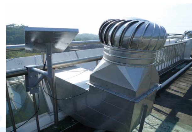
圖書資訊大樓熱浮力通風系統
