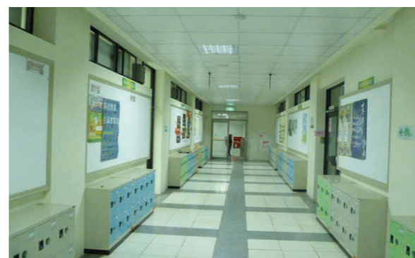
建築物公共空間換裝 LED 照明燈
