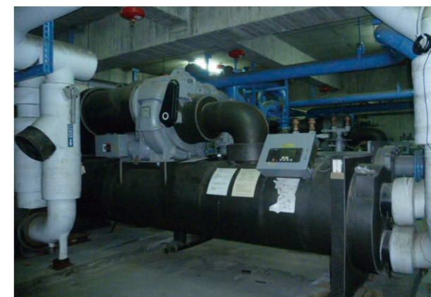
建置中央空調主機智慧化節能控制系統
