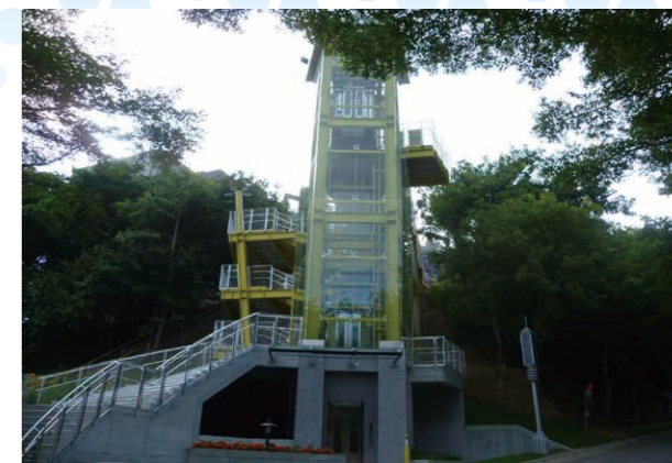
戶外電梯採用高效率馬達及綠能照明
