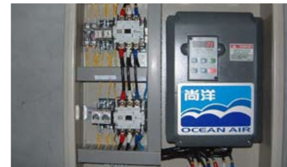
冷氣空調變頻器安裝
