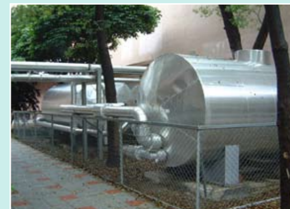
溫水游泳池熱泵系統
