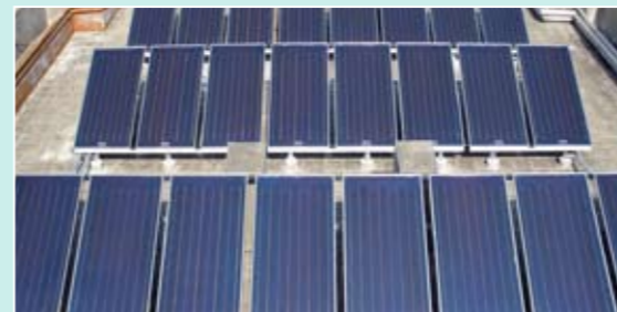
頂樓太陽能熱水器集熱板實景
