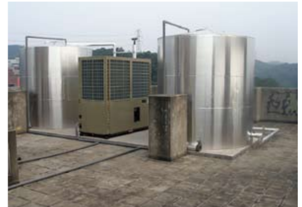
宿舍更換熱泵系統
