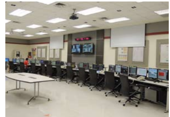
能源調配控制中心
