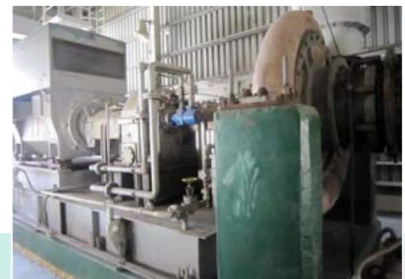
B501空壓機入口風門調整改善
