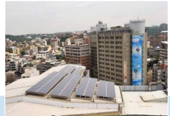
太陽能發電系統
