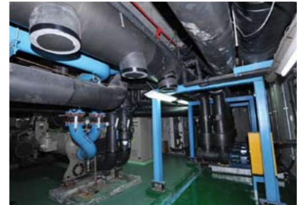
冰水機一次側變流量系統
