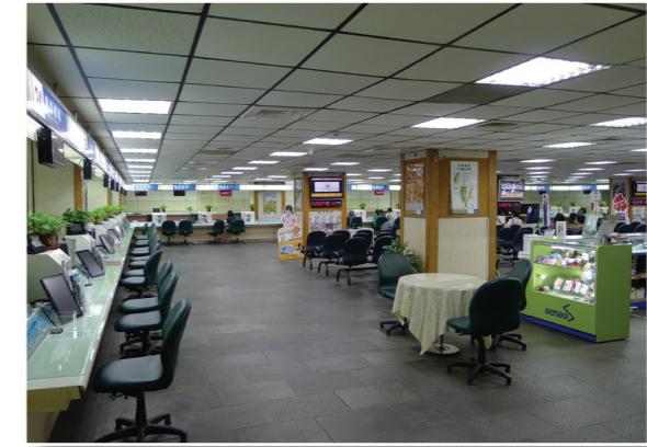
服務中心節能燈具-換裝LED、T5省電燈具節能節費
